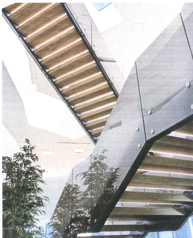
ΣΤΗΘΑΙΑ ΑΠΟ ΚΡΥΣΤΑΛΛΟ TRIPLEX ΜΕ ΚΡΥΦΗ ΕΞΩΤΕΡΙΚΗ ΣΤΗΡΙΞΗ
